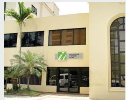
Edificio de la Adm. Local La Feria
